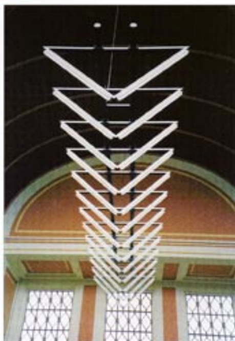
Bahnhofhalle Thun, Leuchter 26-flammig mit Kompakt- leuchtstofflampen
