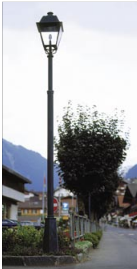
Gstaad, Fussgängerzone Natriumdampflampe SON 70 W
